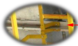
Fixação da Escada e Guarda Corpo
